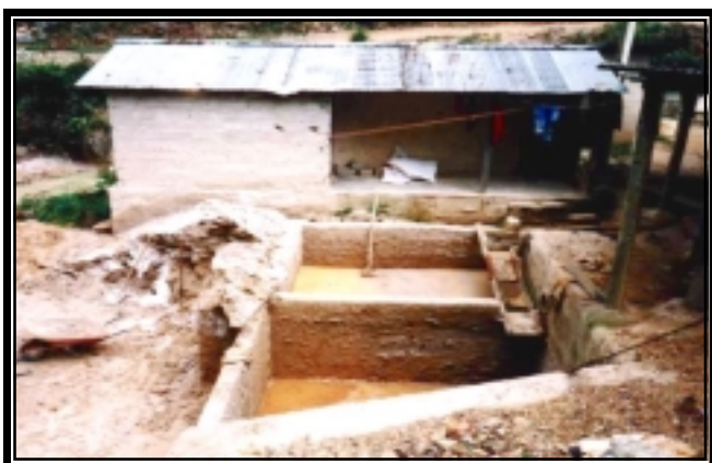
Figura 16a. Antiguas instalaciones de La Plata (California).
